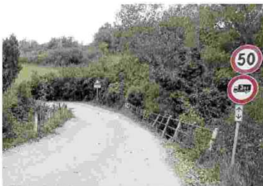
Il ponte sulla strada provinciale 130 valle di Teva
