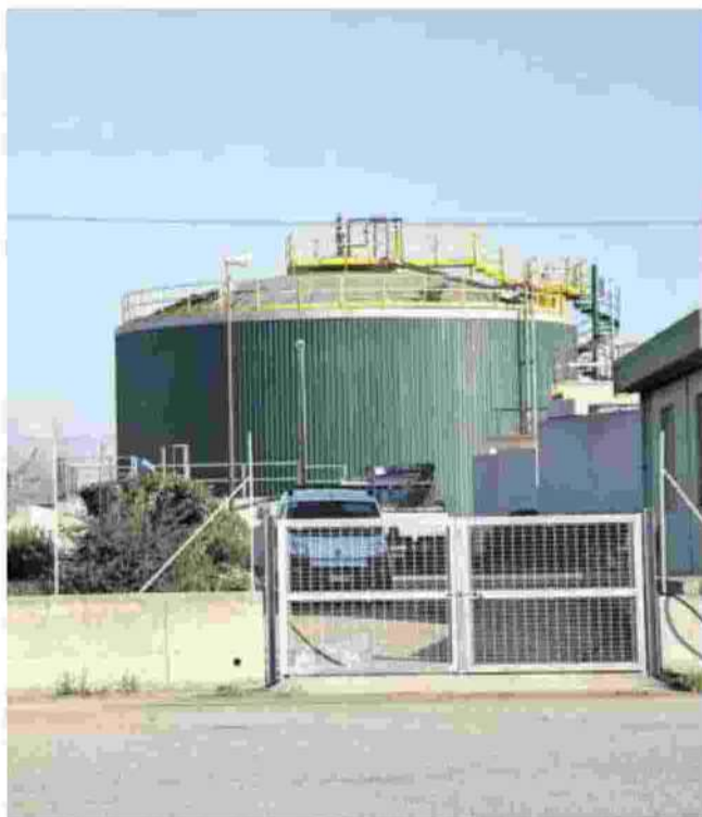
Il depuratore di San Marco potrà fornire risorsa idrica all'agro
