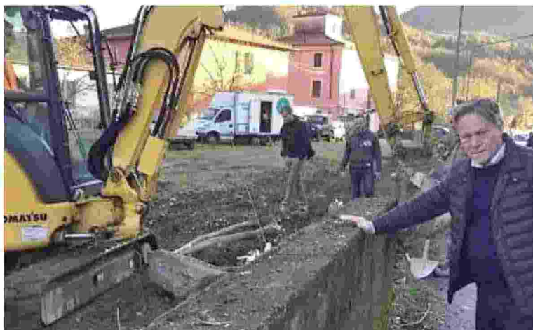
Il sindaco controlla l'eliminazione del muro di via Tambura ad Aulla
