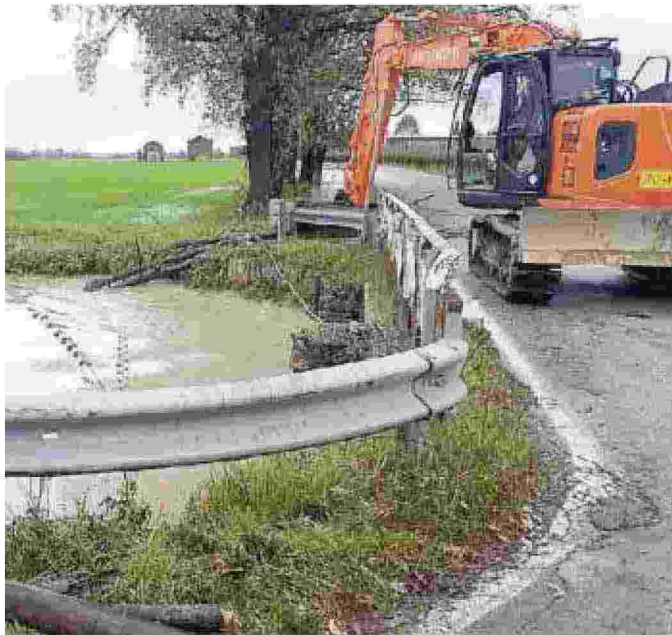
L'intervento su un canale durante le piogge intense di novembre
