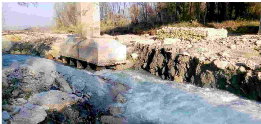
I pali delle fondazioni che sostengono un pilone del Ponte Verucchio
