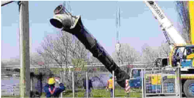
Irrigazione a pioggia: un cantiere a San Matteo ARCHIVIO
