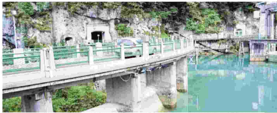
La strada della destra lago che sarà interessata da oggi dai lavori per far partire lo sghiaiamiento
