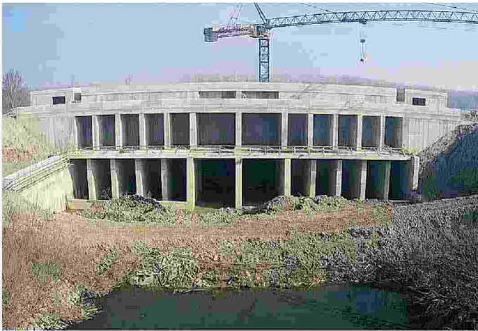
Il cantiere della controchiavica in località Moglia di Sermide
