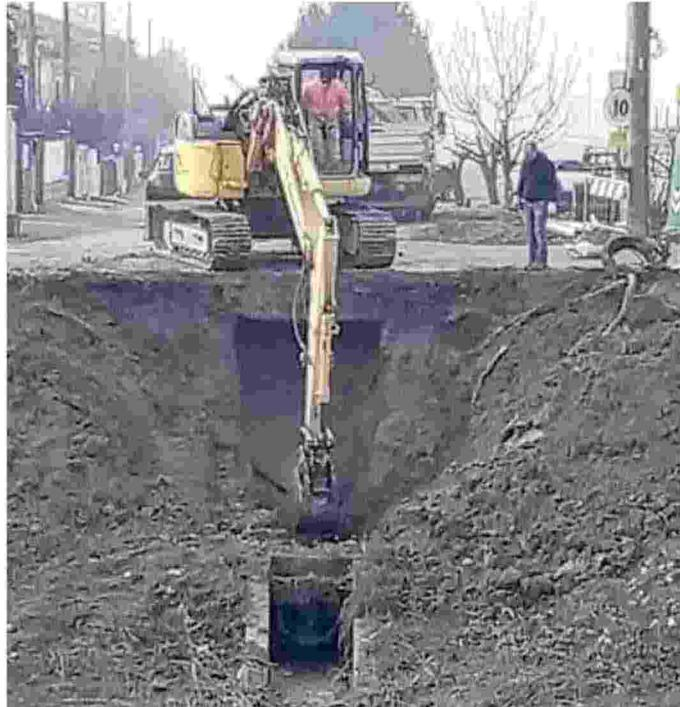
Donizzetti, la strada adiacente che è comunale, aveva una rottura importante da tempo. L'acqua uscendo spingeva il terreno, arrivando fino alla sponda del canale e ovviamente a quello che sarà l'innesto con la pista ciclabile, che dovremmo completare, del nuovo ponte. A quel punto la rottura è stata sistemata. Adesso aspettiamo di vedere come reagirà il terreno e se re-
