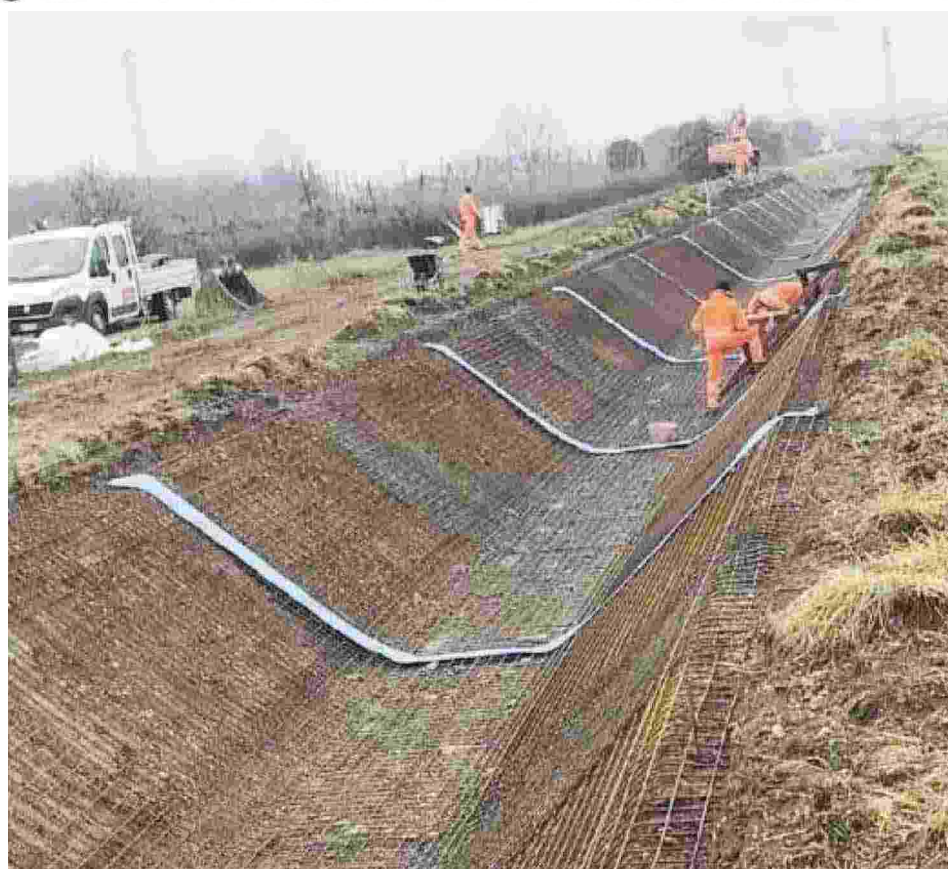
Lavori del Consorzio per il ripristino delle sponde di un canale demaniale (FOTO DALLA PAGINA FB DEL CONSORZIO)
