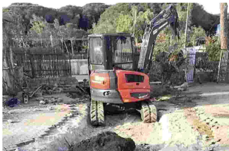
I lavori al fosso di Segagnana
