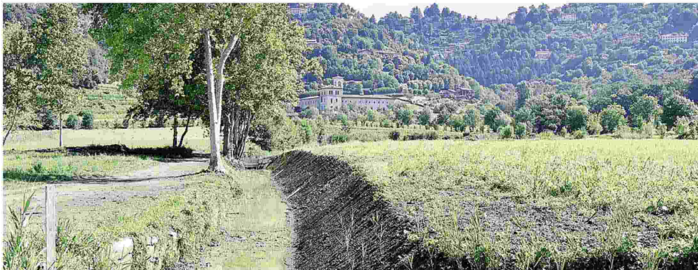
I reticoli idrici della valle di Astino sono la causa dei gravi allagamenti nel quartiere di Longuelo. Le tre vasche di laminazione sono la soluzione studiata per prevenire nuovi disastri
