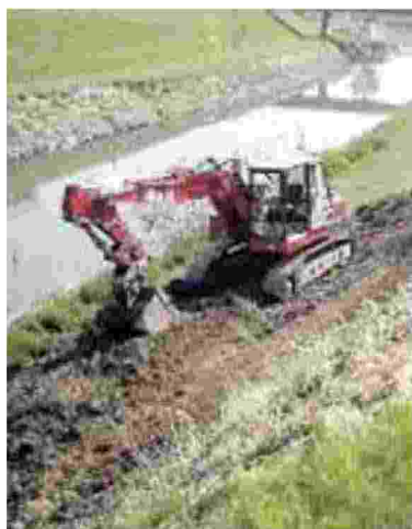
LAVORI Opere sull'argine
