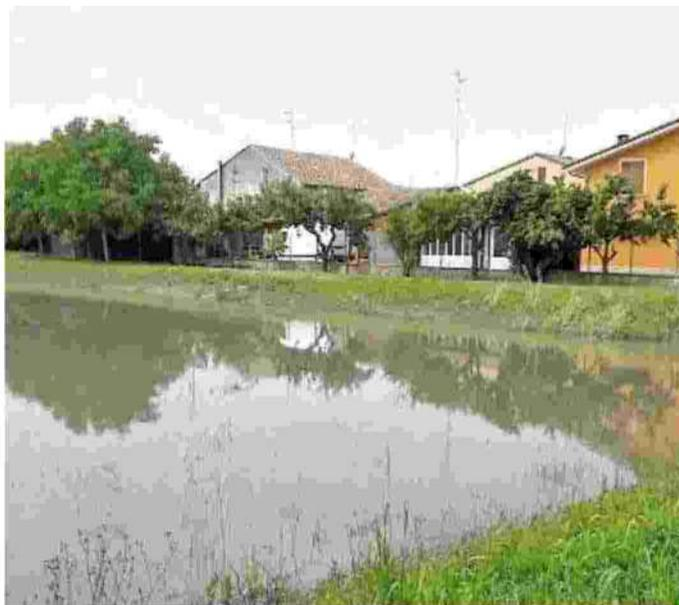
Una delle vasche di laminazione: la capacità complessiva è di 60mila metri cubi
