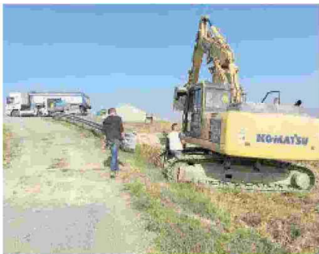
LAVORI Interventi precedenti sulla strada della Boffalora.
