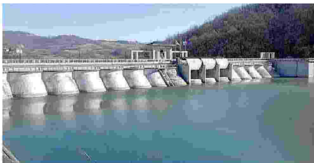
Così si presenta ora la diga del Molato in comune di Alta Val Tidone
