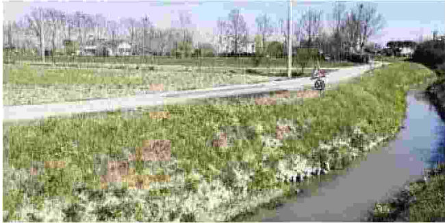
L'argine dello scolo del Pionca a Dolo sarà rinforzato
