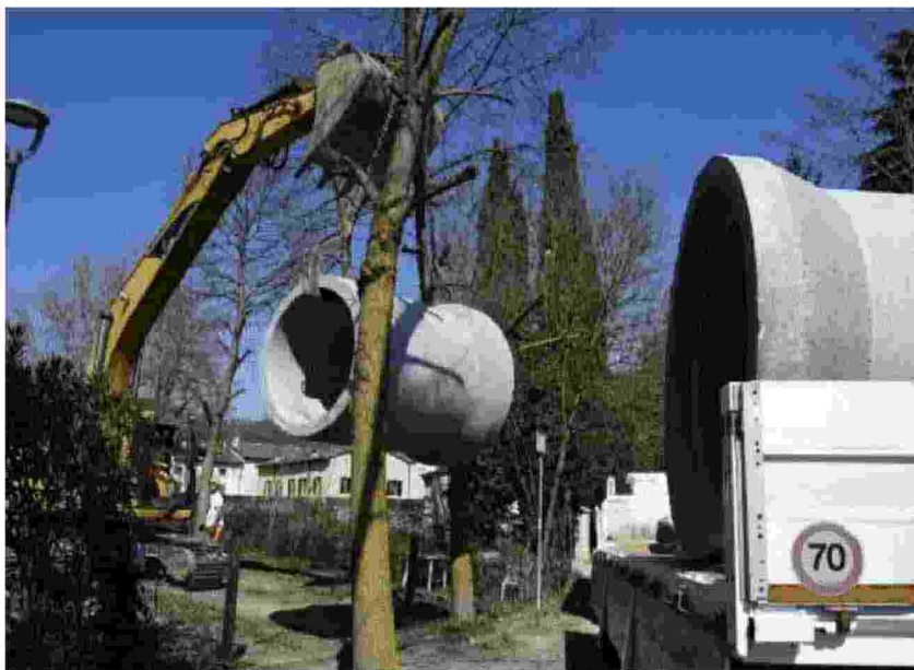
I lavori in corso lungo il Progno FOTO PECORA
