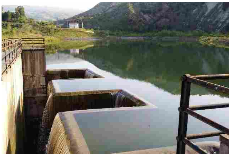
Vasca sul fiume Simeri in fase di riempimento
