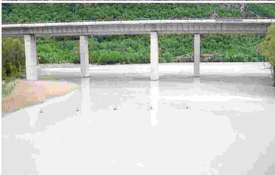
Lo scarico della centrale idroelettrica di Somplago rende torbido il lago dei Tre Comuni
