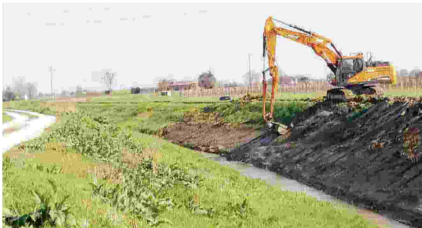
Interventi di ripristino allo scolo Tratturo a Lugo
