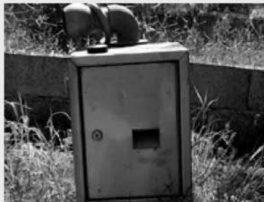
La centrale di irrigazione, da oggi in funzione
