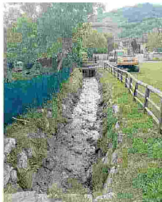
I lavori lungo il Rio Marocco
