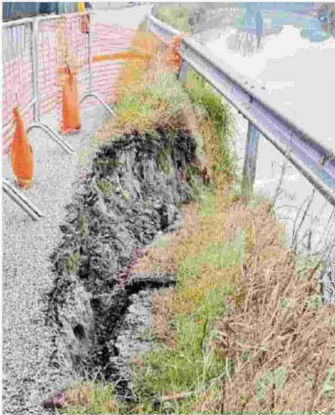
Una frana lungo il Naviglio, in corrispondenza di via Ariosto
