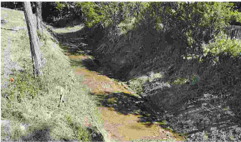
Borro della Doccia Nell'area i lavori del Consorzio di Bonifica 2 Altovaldarno
