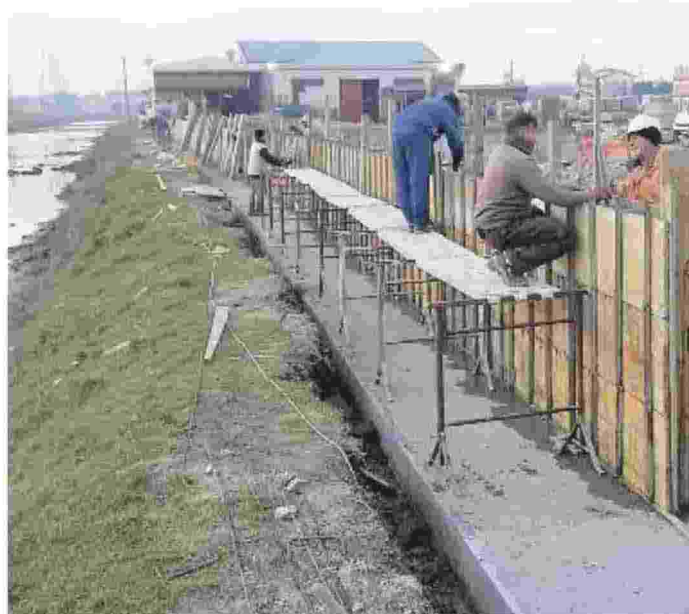
I cantieri riguardano i canali Vena e Venone
