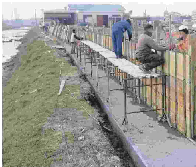
I cantieri riguardano i canali Vena e Venone
