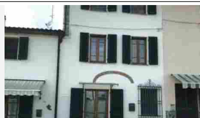
Appartamenti Vecchiano Filettolo, Via delle Prata, 24 - 184000
