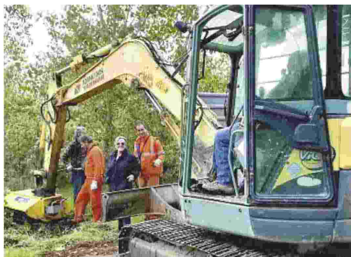
Sono già partiti i lavori di manutenzione sui torrenti per mettere in sicurezza gli argini e per prevenire eventuali esondazioni
