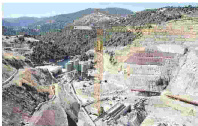
Il cantiere della diga in costruzione da oltre trent'anni
