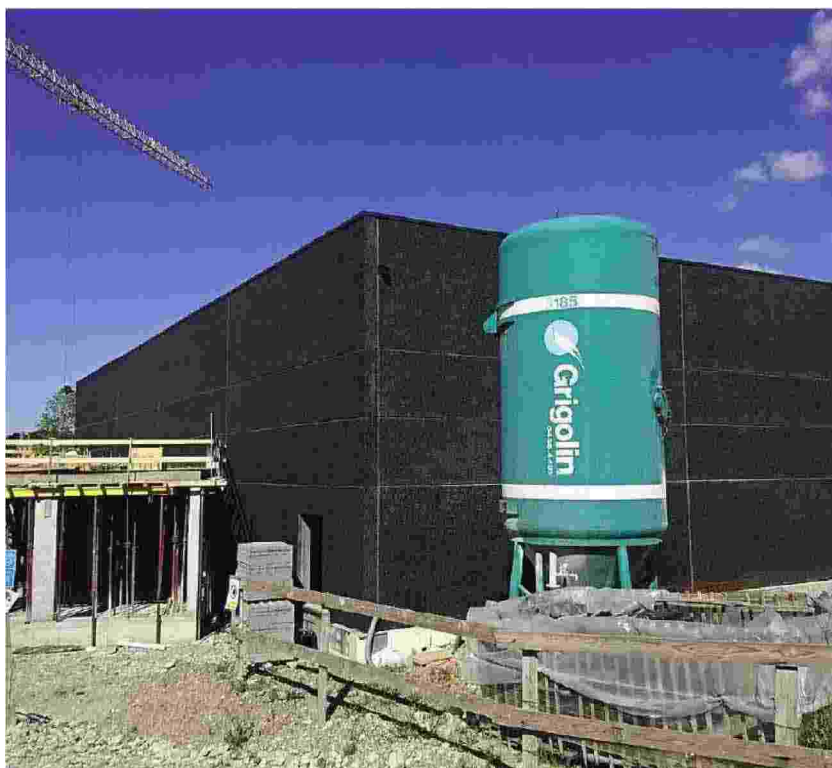
Il cantiere per il PalaPonte, una delle opere che caratterizzeranno quest'ultimo anno dell'amministrazione Zirafa
