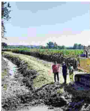
Il cantiere sul rio di Ponzano
