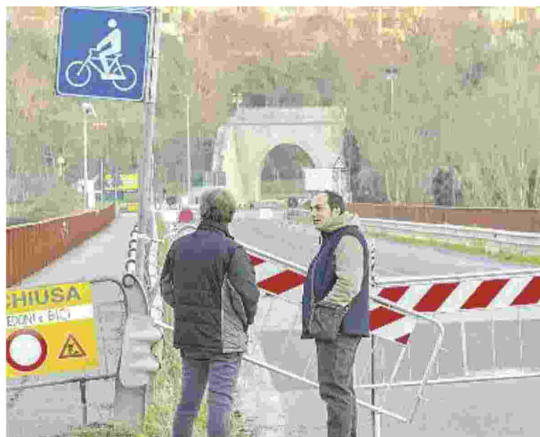
Il ponte di Verucchio era stato chiuso al traffico prima di Natale
