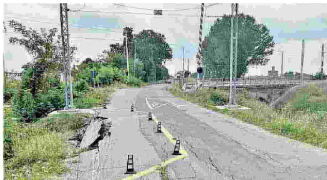
Il tratto di strada della Pavese Piombina interessato ai lavori FOTO LUNARDINI
