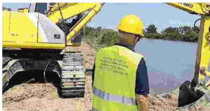
I tecnici ieri all'opera per la ricostruzione dell'argine ceduto sabato
