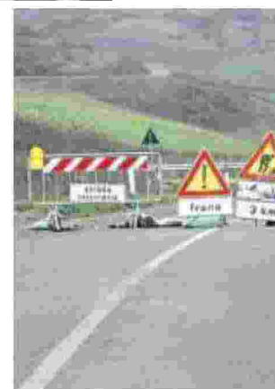
Lavori sulla Sassari-Nulvi
