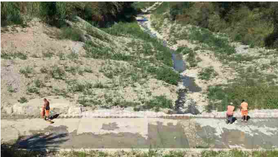
L'intervento di bonifica del fiume Conca.
