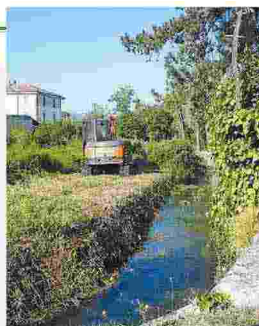
Cantaro Terminati i lavori di pulizia
