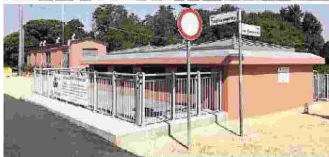
L'inaugurazione dell'idrovora che sorge a Riviera
