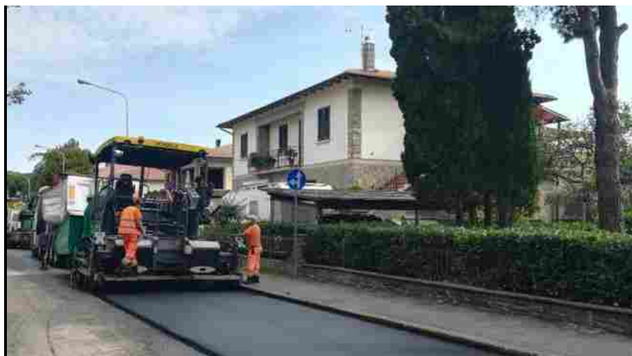
Asfaltatura strade Tavarnelle
