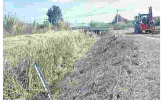
Lavori di pulizia sul bordo di un canale
