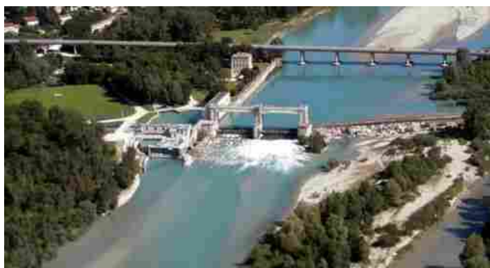
FOTO – deviazione dal Piave a Fener
