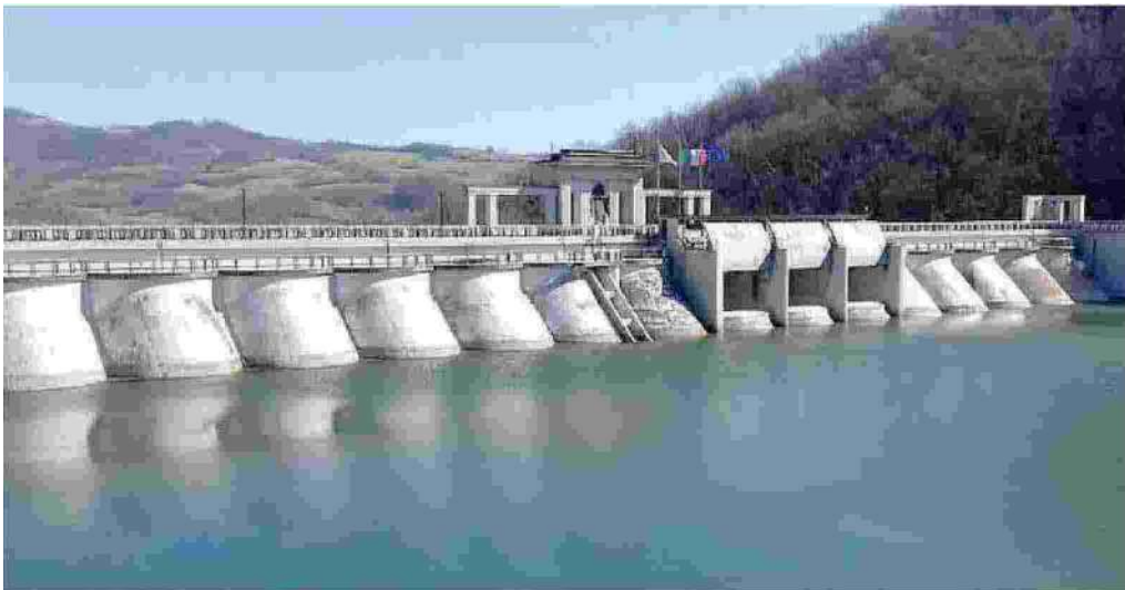
I lavori di manutenzione alla diga di Mignano dovrebbero concludersi il 20 novembre FOTO LUNARDINI
