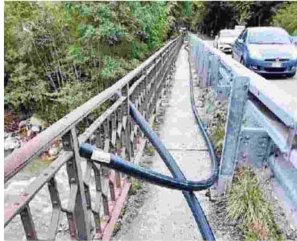
Il bypass con cui è stato salvato il servizio a Vidracco
