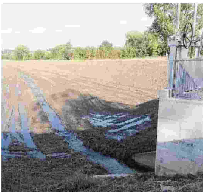
La zona interessata dai lavori
