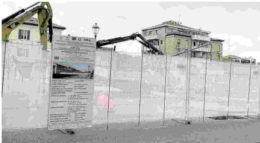
Il cantiere per il ponte 2 Giugno che al momento è fermo
