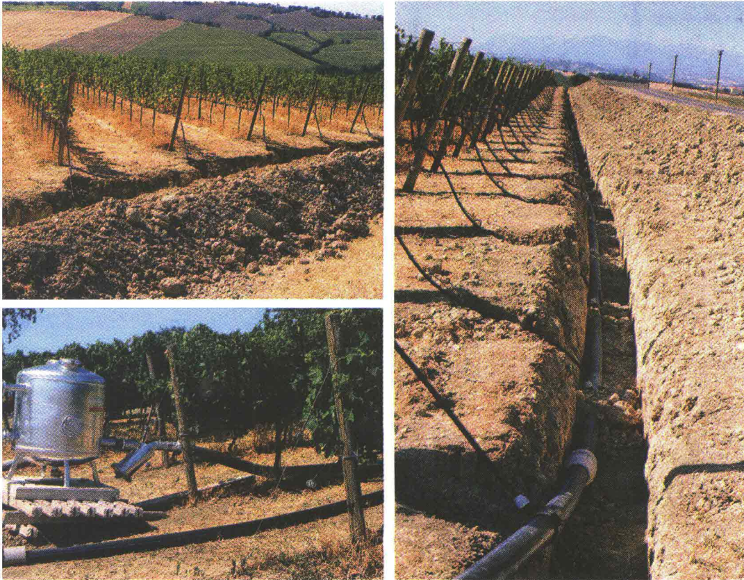
► Fig. 1. A partire da un punto di prelievo dotato spesso di pompa, serbatoio di accumulo e apparato filtrante, tramite una rete di tubazioni principali (spesso in buona parte interrata), l'acqua arriva alle ali gocciolanti complete di microerogatori, collocati in prossimità delle piante da irrigare
