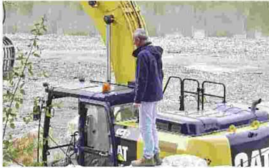
Uomini e mezzi all'opera lungo le sponde del fiume
