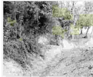
pulizia mediante la trinciatura del materiale vegetale vivo e la rimozione del materiale vegetale morto in alveo. Si è poi proceduto alla riprofilatura.
