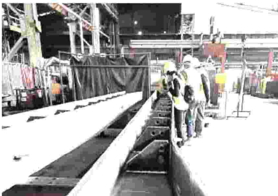
Gli operai al lavoro a Pordenone 3a1a6632cc39752977800d138
