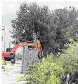
I lavori sul fosso Rigatta
