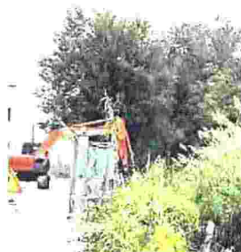
I lavori sul fosso Rigatta
