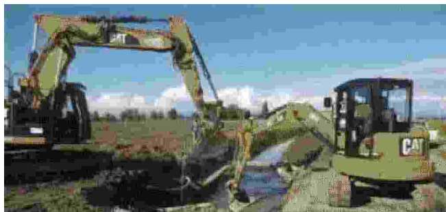
Le operazioni di ricostruzione del ponte sullo scolo Carpenedolo
