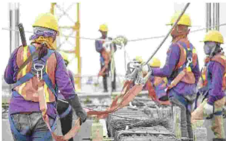
Operai al lavoro. Tanti interventi fatti e ancora da fare sui corsi d'acqua
