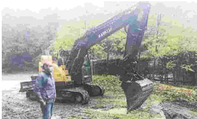
Il sopralluogo dei tecnici al cantiere nel torrente Elzana
