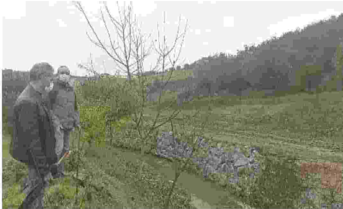
Il sopralluogo sull'argine del torrente Elzana, nella frazione di Comeana, nel tratto del ponte di via della Stazione e del parco della Fontina
