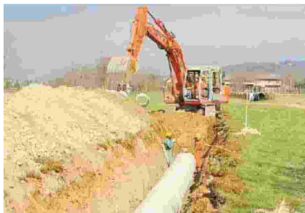
Operai del Consorzio Piave al lavoro per interrare una condotta idrica
