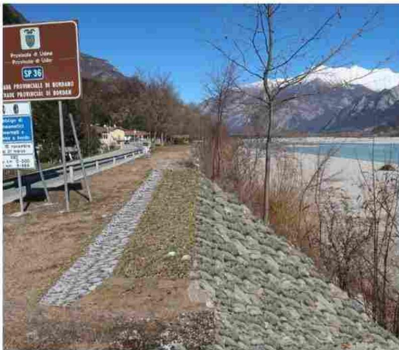
Figura 5: Rendering del rialzo della scarpata.
