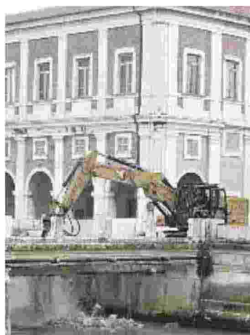
Il cantiere sul ponte 2 giugno
