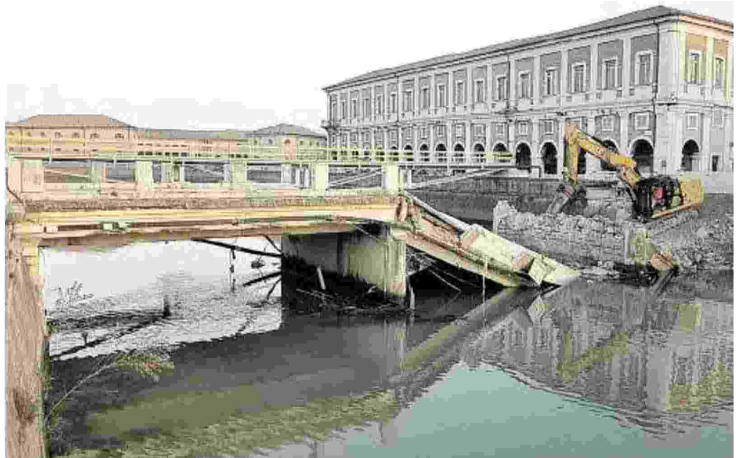
La demolizione del ponte 2 Giugno è stata anticipata
