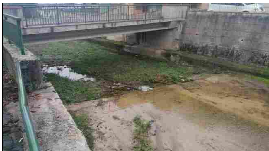
Lavori sui torrenti a Cavriglia
