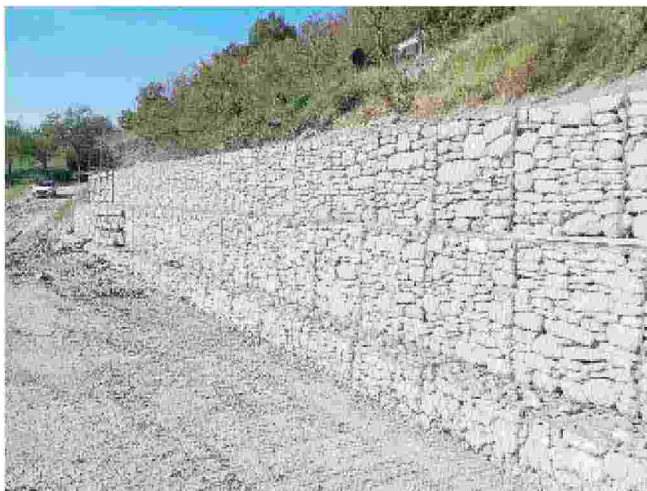
MORAGNANO La strada messa in sicurezza.
