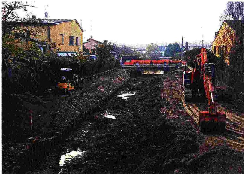
**I lavori di riqualificazione del canale Sorgive nella frazione viadanesa di San Matteo delle Chiaviche. Lungo una delle rive verrà realizzata una pista ciclabile al posto del sentiero**
