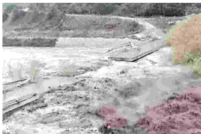
Il Cedrino in piena ricopre u ponte distrutto anni fa
