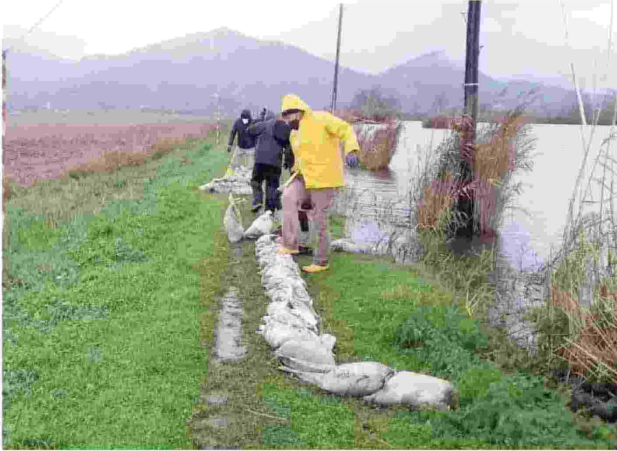
Sopra, gli operai del Consorzio di Bonifica al lavoro per mettere i sacchi di sabbia lungo l'argine del Quiesa per arginare la piena. In alto a destra una foto di Massimiliano Simonini scattata a Torre del Lago: l'acqua ha rotto i pontili lungo il Belvedere. In basso a destra la piena della Gora di Stiava scattata da Alberta Puccinelli.
