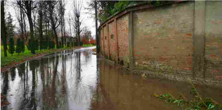
Nella foto via Muratori a Cappella allagata
