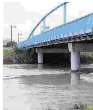
Il ponte di Tencarola (Piran)
