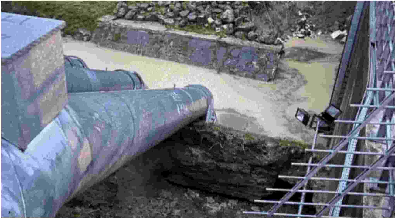
L'intervento alla roggia Caveggiara per rimettere urgentemente in sicurezza il collegamento del canale con il fiume Tesina
