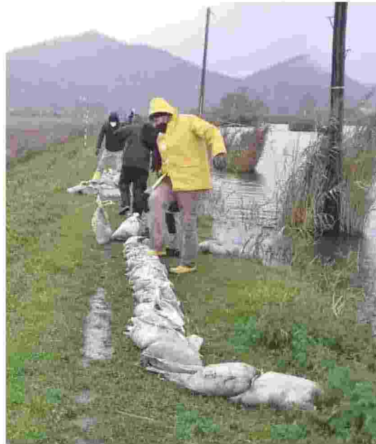
Sacchi di sabbia per consolidare gli argini del lago di Massaciuccoli
