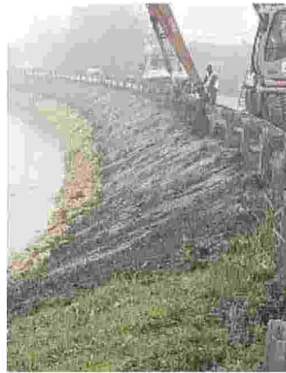
Lavori lungo l'argine a opera del Consorzio di Bonifica
