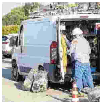
Tecnici di Enel al lavoro
