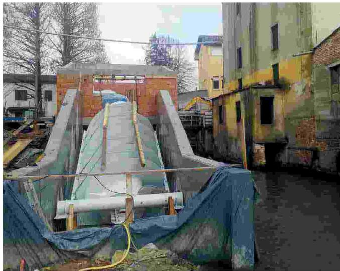
La turbina a coclea dopo essere stata collocata all'interno dell'impianto
