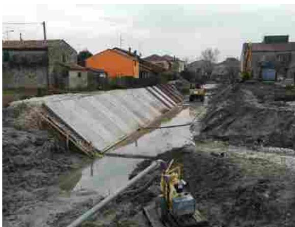
Sta avanzando anche l'opera necessaria a far fronte alle frane sul Canale Naviglio in fregio a via Ariosto. Si sta andando avanti con il rivestimento del fondo in cemento armato ed è anche stato realizzato un tratto del rivestimento della sponda, dopo la ricostruzione con sasso e ghiaione. Questa lavorazione, a completare il consolidamento dell'intera sezione trapezoidale, si susseguirà con le medesime modalità per tratti, fino al ponte.
