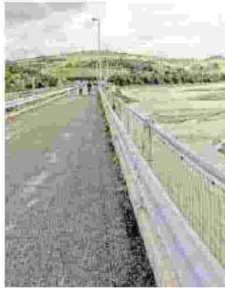
La traversa sul Secchia
