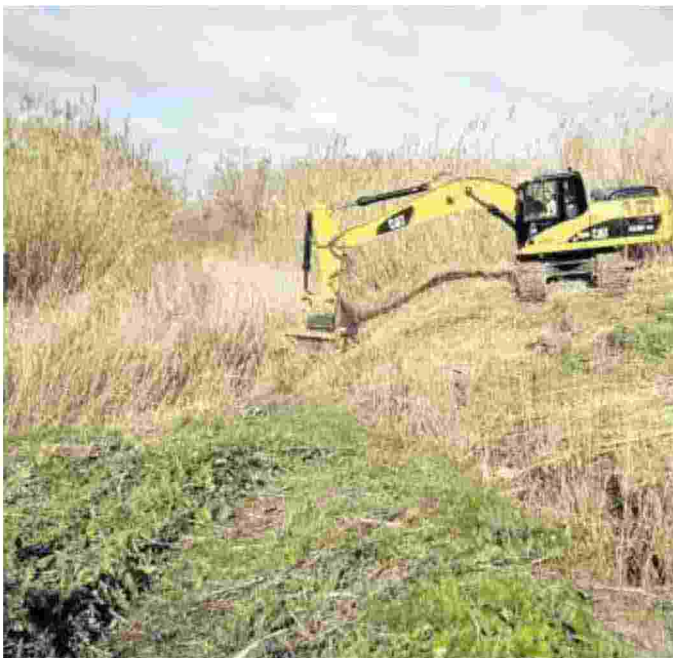
Lavori di pulizia degli alvei
