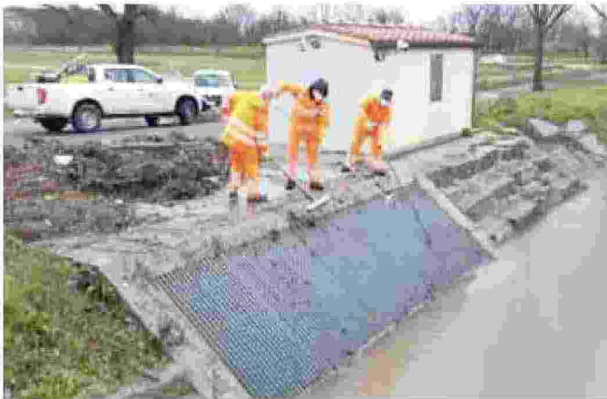
Operatori del Consorzio Medio Valdarno al lavoro
