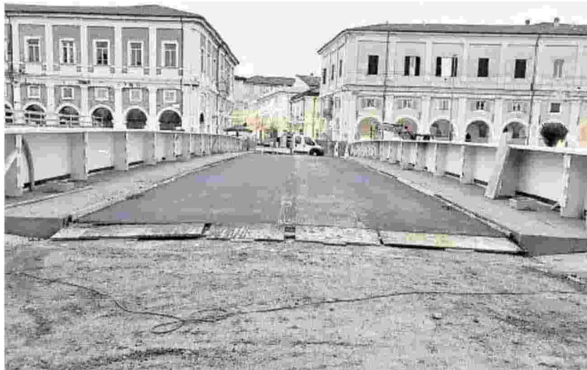
Martedì scorso il ponte 2 Giugno è stato asfaltato
